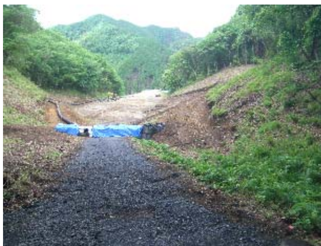
【工事着手前（粟沢中流工区）平成27年3月】
