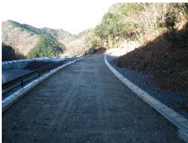
【完成状況（粟沢中流工区）平成27年12月】
