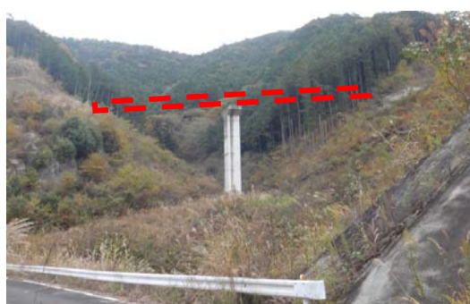
付替県道5号橋上部工工事
