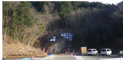
付替県道2号トンネル工事 【施工状況（平成28年12月）】
