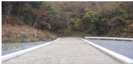
付替県道2号トンネル工事 【工事着手前（平成28年10月）】
