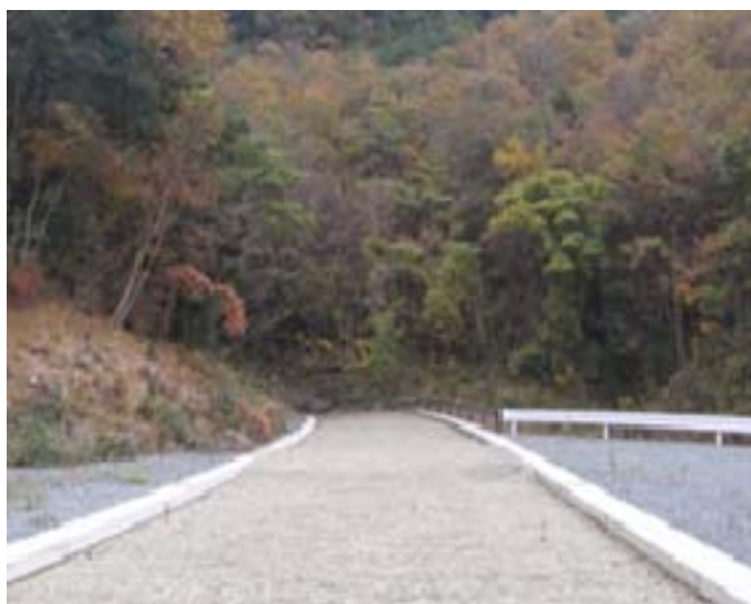
工事着手前(平成28年10月)
