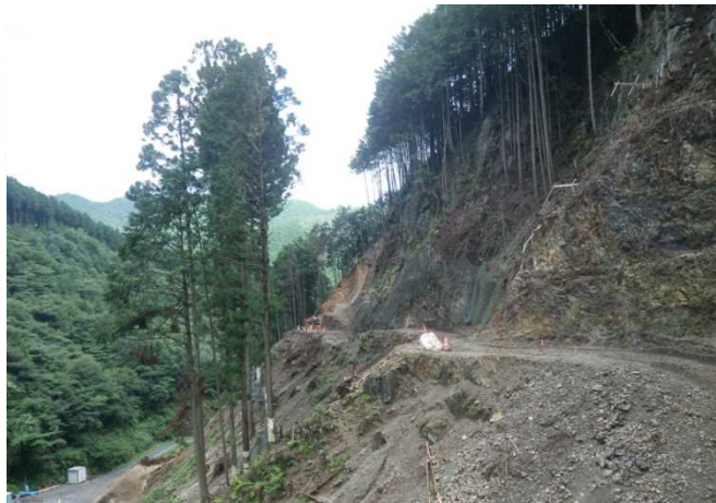
付替林道和田6工区他工事
