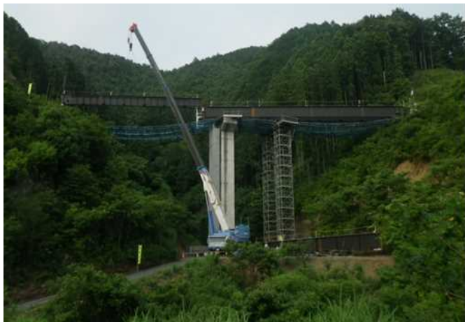
付替県道5号橋上部工工事
