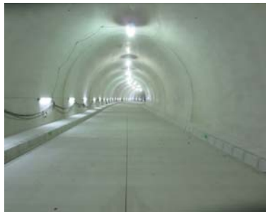
付替県道2号トンネル工事 【工事完了（平成29年12月）】
