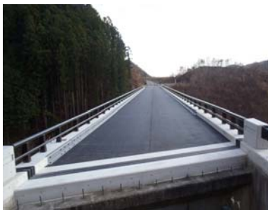
付替県道5号橋上部工工事 【工事完了（平成29年12月）】
