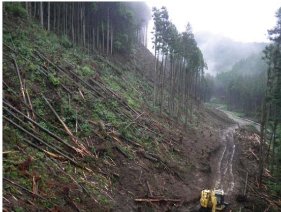
付替林道和田6工区他工事 【工事着手時状況(平成29年6月)】
