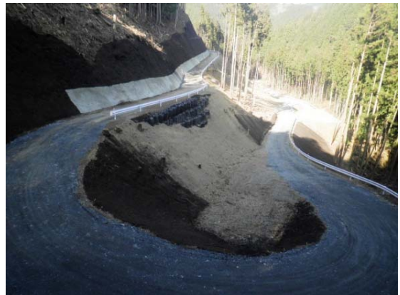
付替林道和田6工区他工事 【工事完成状況(平成30年3月)】
