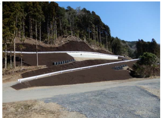
付替林道西ノ入1工区他工事 【工事完成状況(平成30年3月)】
