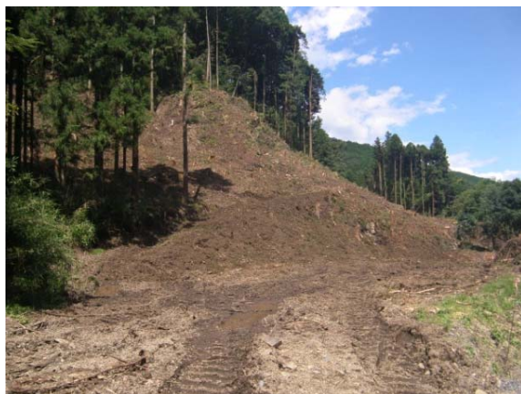
付替林道西ノ入1工区他工事 【工事着手時状況(平成29年6月)】
