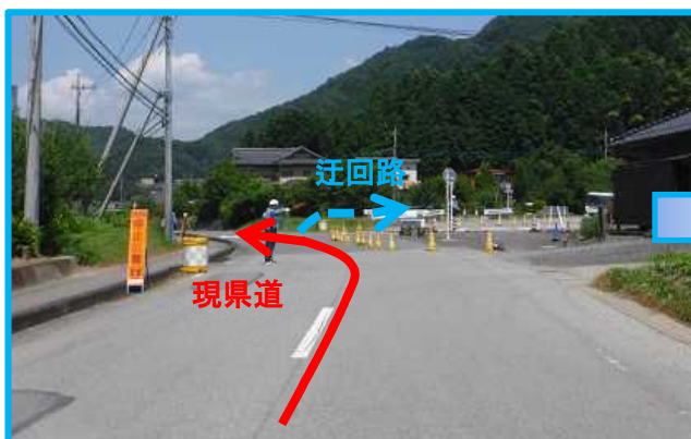
工事着手直後（平成30年7月）
