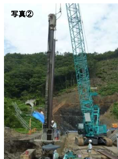
鉛直連続遮水壁の工事状況
