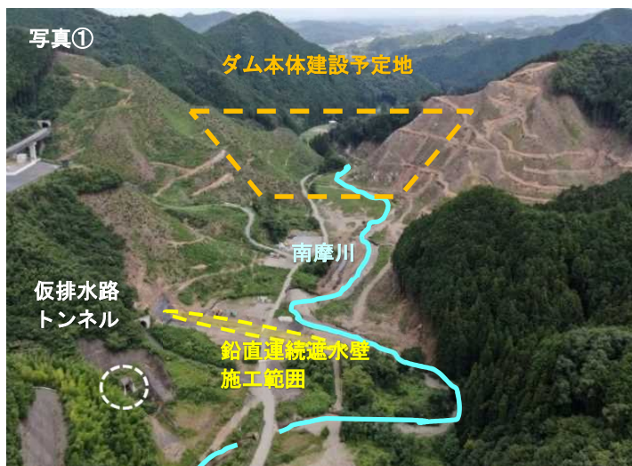
ダム本体の建設工事周辺状況
