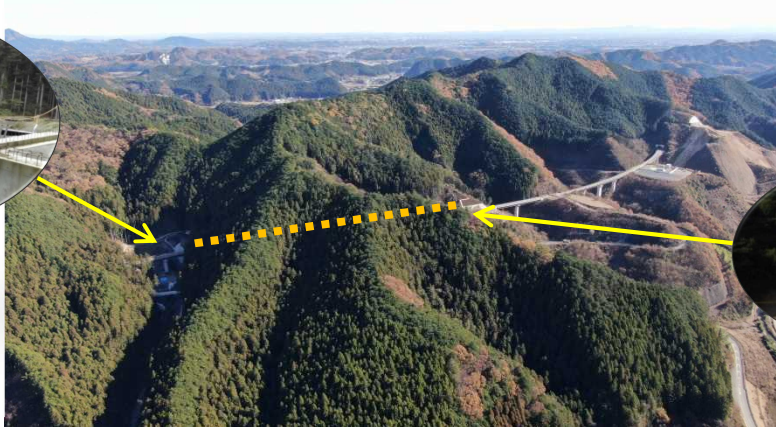
ドローン撮影による工事状況写真
