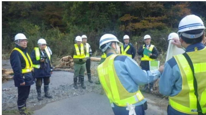
南摩注水工予定地の状況確認
