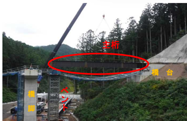
移動式クレーンによる架設状況
