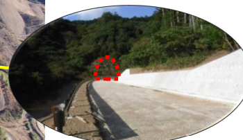
中村3工区(完成工区) 下流側より撮影
