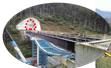
4号橋上部工(施工状況) 上流側より撮影
