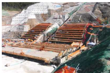
河床部グラウチング状況
