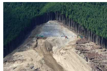
堤体右岸基礎掘削状況
