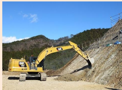
「①掘削」→「②法面整形」
