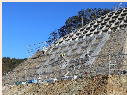
「④法枠設置・吹付」
