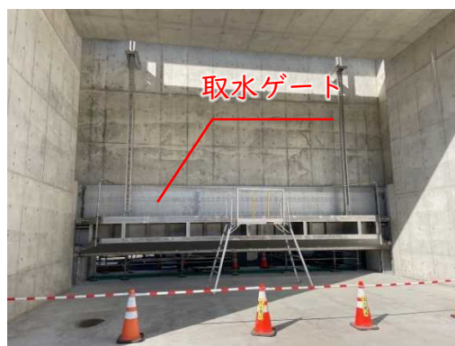
写真-4 取水ゲート (大芦川取水放流工)
