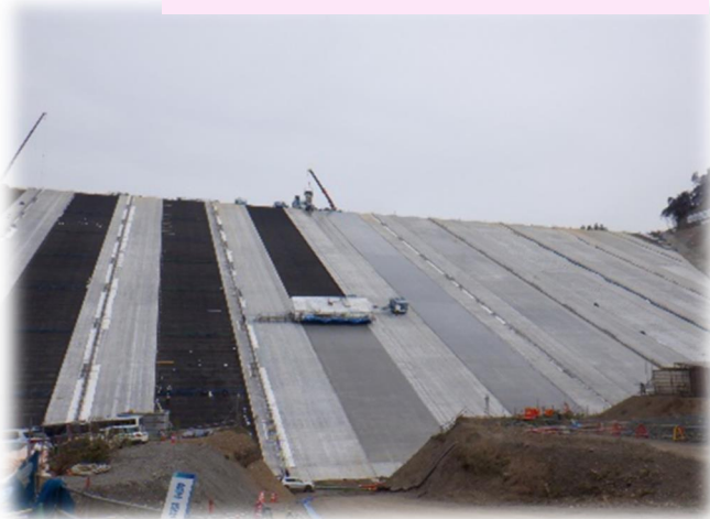
工事状況写真(令和6年4月11日)
