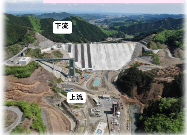
工事状況写真(令和6年4月25日)
