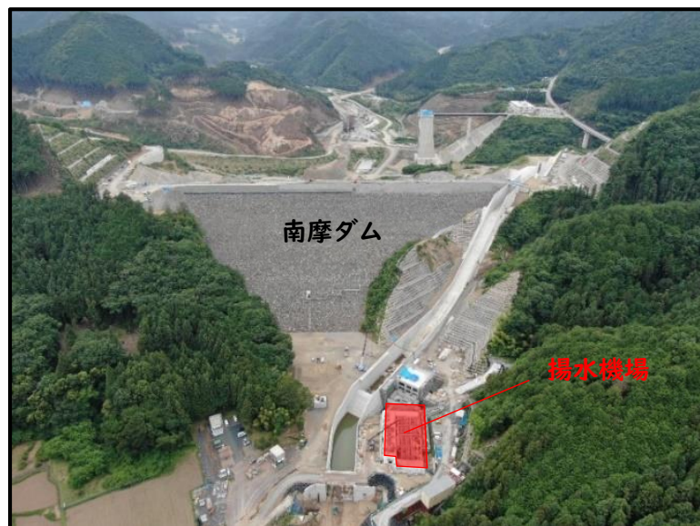
写真-1 ダム下流部の様子
