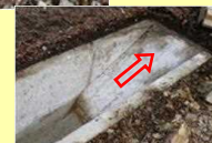
● スロープ付き側溝
