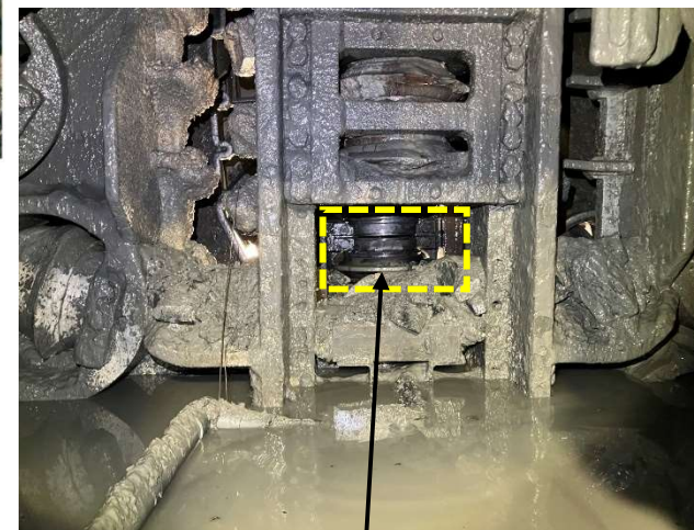
大芦工区側から確認した 南摩工区のシールドマシン
