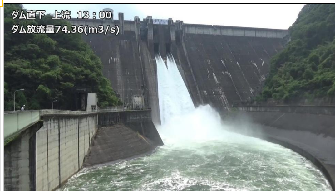
写真 最大放流時のダム洪水吐ゲートの様子
