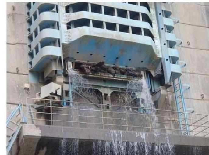
図 20 平成 29 年 裾花ダムにおけるコンジットゲート閉塞状況
