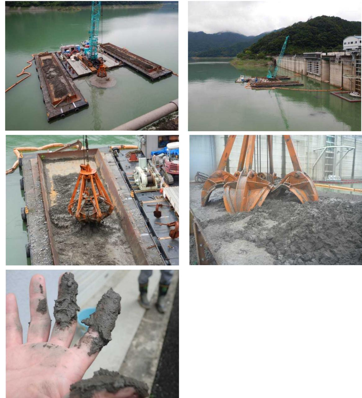
図 35 取水口付近の浚渫状況と浚渫土
