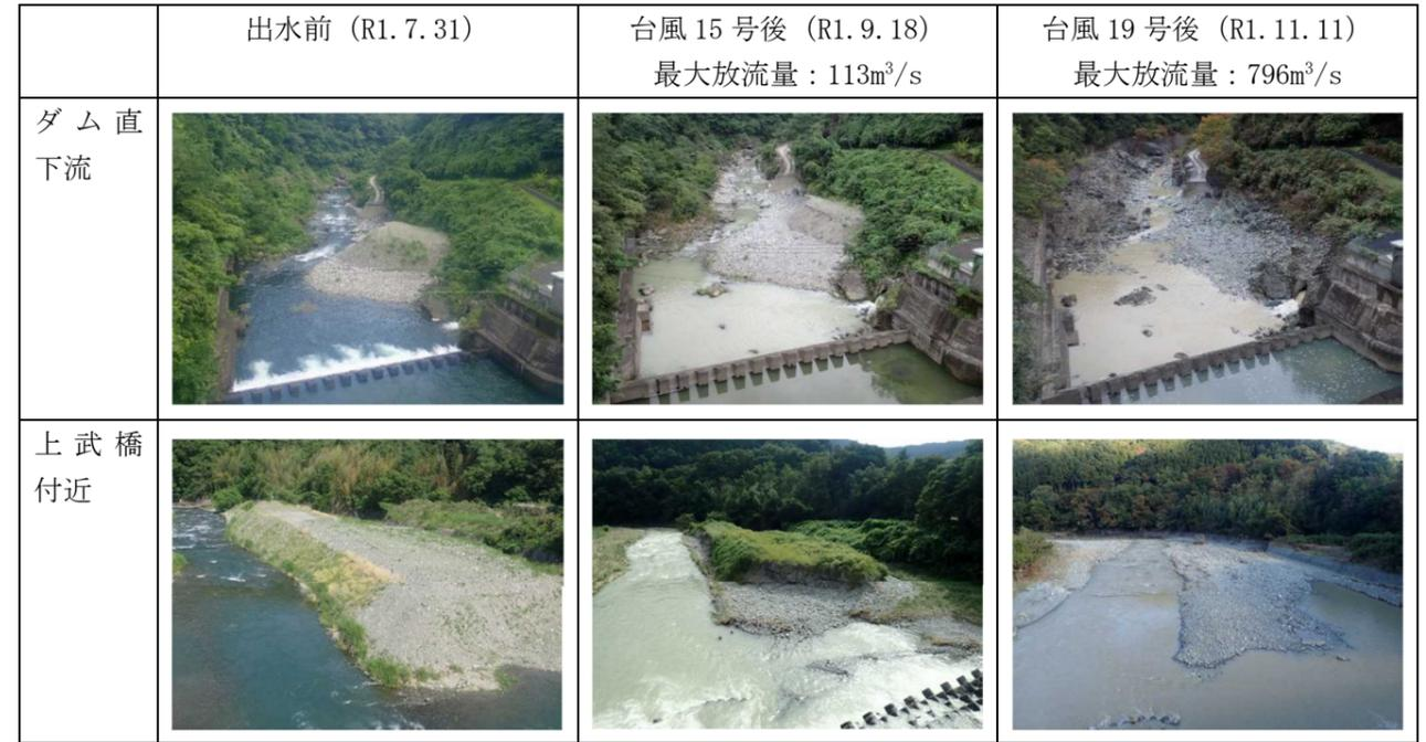
図 29 下流土砂還元土砂の置土及び流下状況
