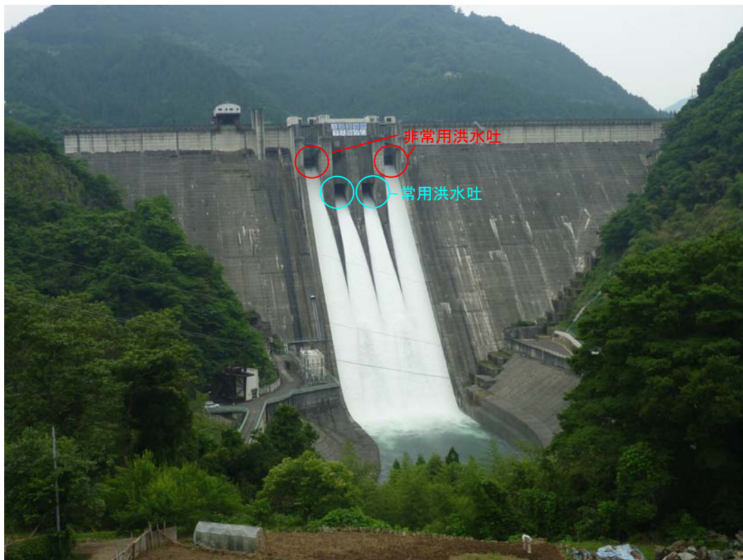
写真：平成 22 年 6 月の点検放流
