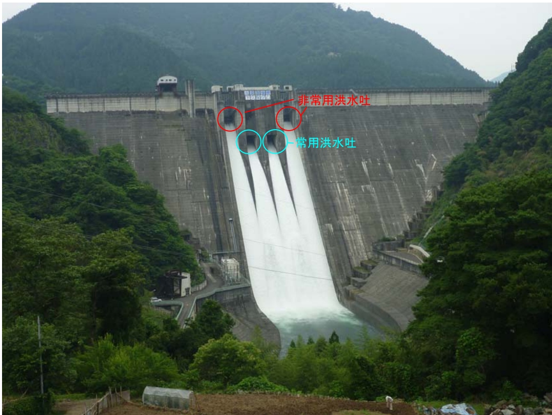
写真：平成 22 年 6 月の点検放流
