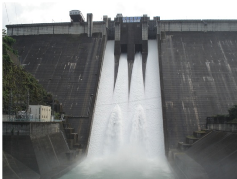
写真：平成22年6月の点検放流
