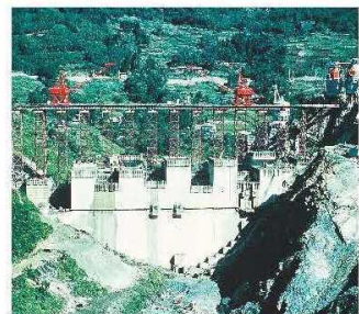
ダム建設工事
