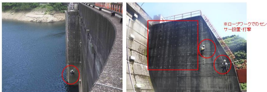
弾性波トモグラフィ法によるコンクリート健全度調査
