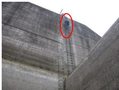
減勢工床版コンクリートの調査(移動状況)
