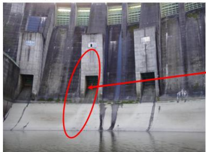
アーチ式コンクリートダム導流部の目視点検
