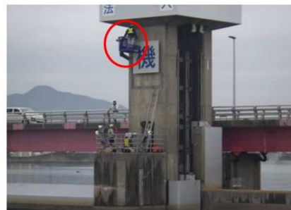
河口堰におけるセンサ貼付作業
