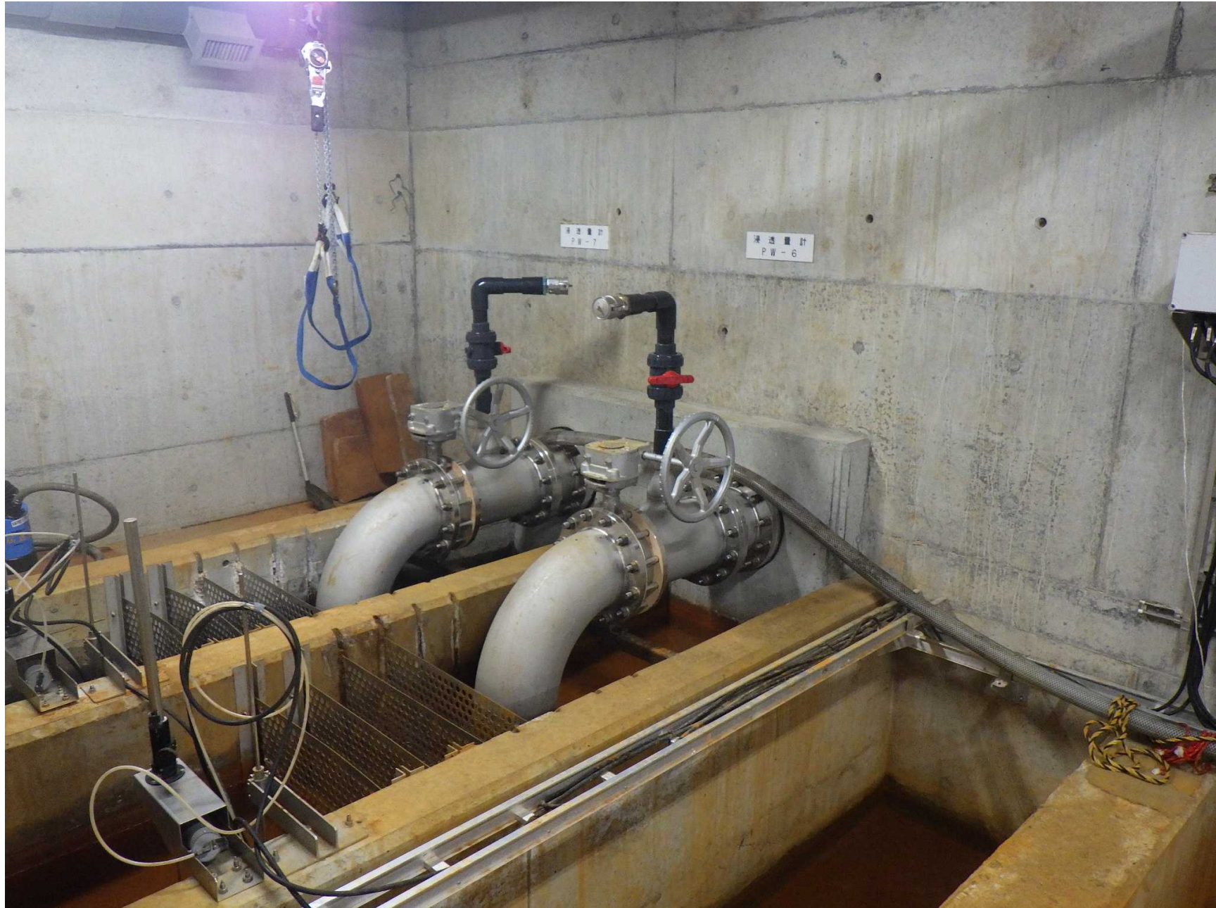
導水管吐口(管徑250mm)
