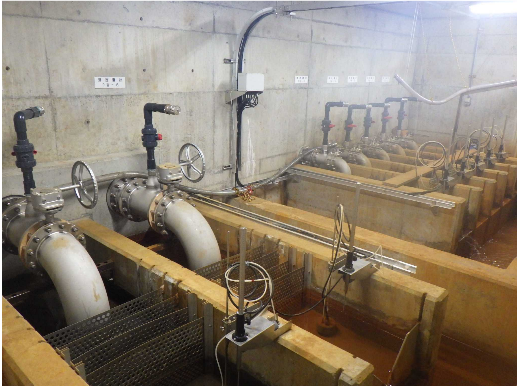
浸透量観測室の内部(全景)
