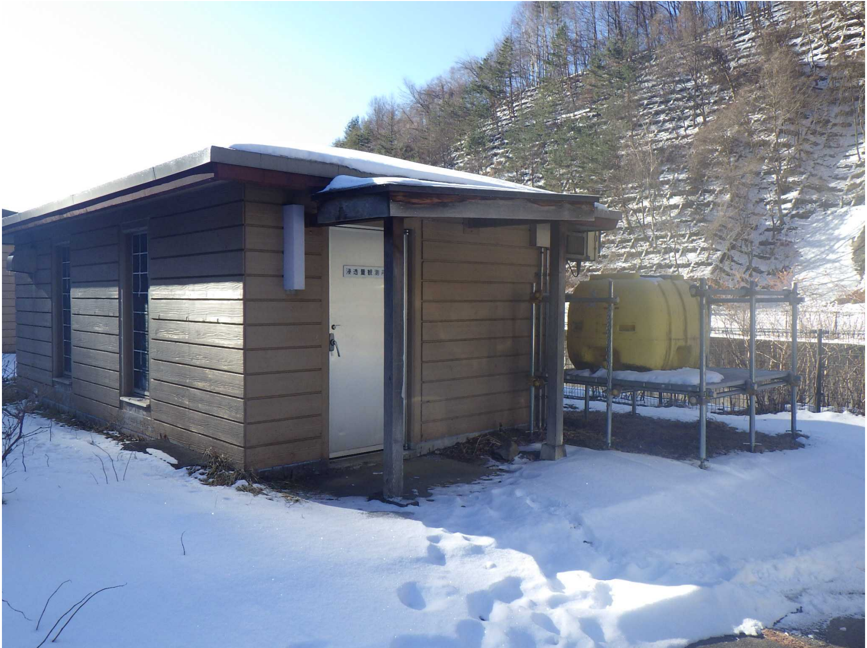
浸透量観測室の外観
