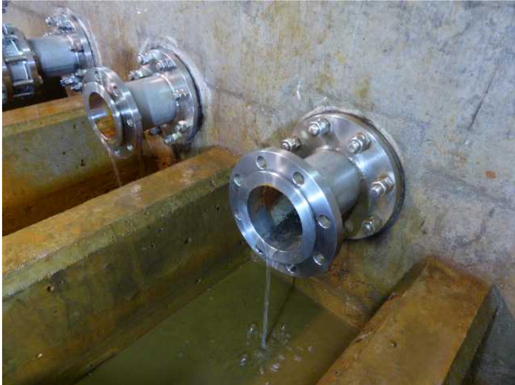
導水管(管径150mm・フランジ管撤去時)
