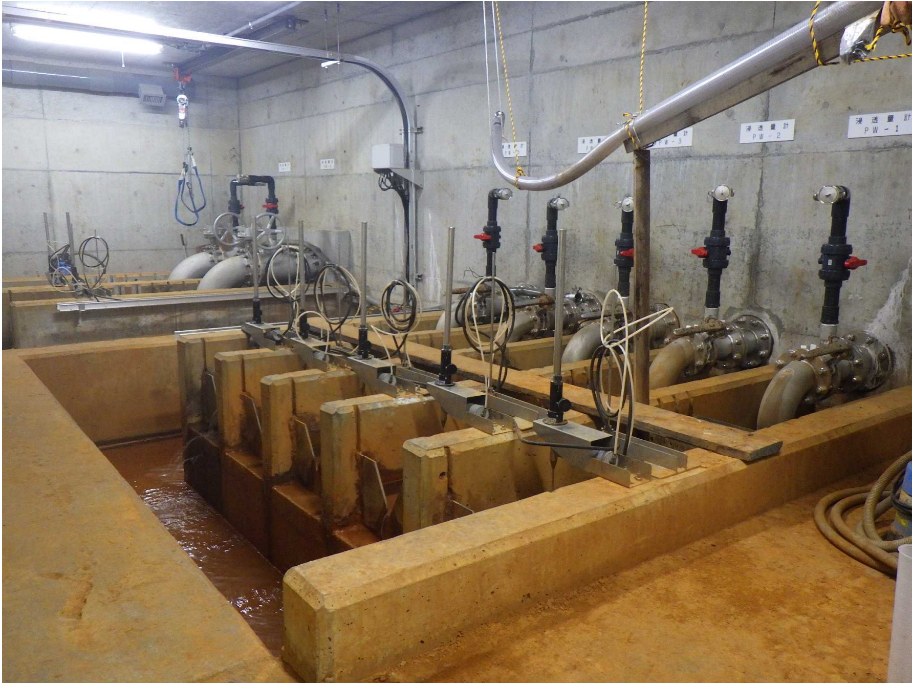
浸透量観測室の内部(全景)
