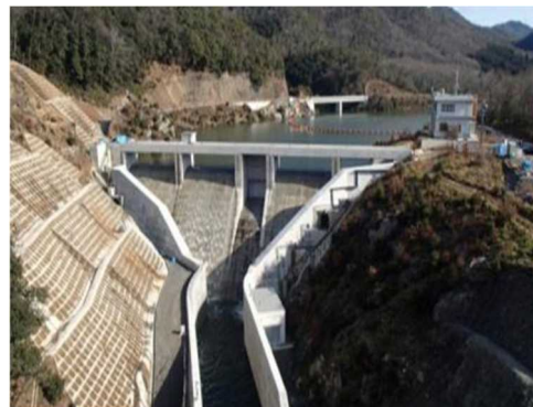
試験湛水中のダム
