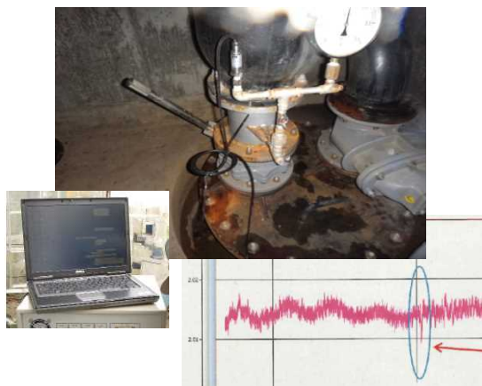
圧力センサーによる管路診断
