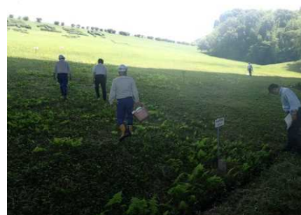
堤体法面の湿潤状況の確認
