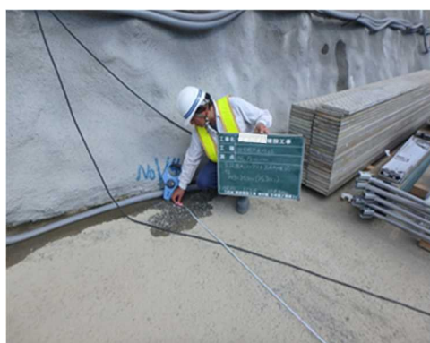
施工監理（現場立会い確認状況）
