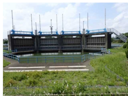
耐震照査対象施設
