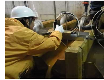
監視項目の計測状況の確認
