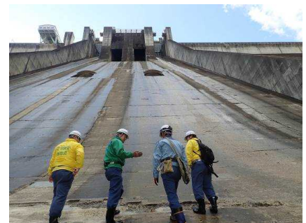
ダム洪水吐きの検査状況
