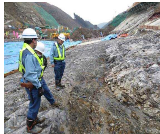
ダム基礎地盤の確認・評価
