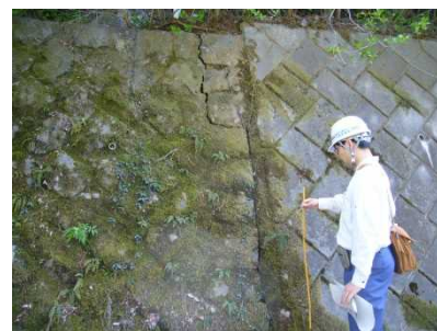
現地調査（擁壁の変状調査）
