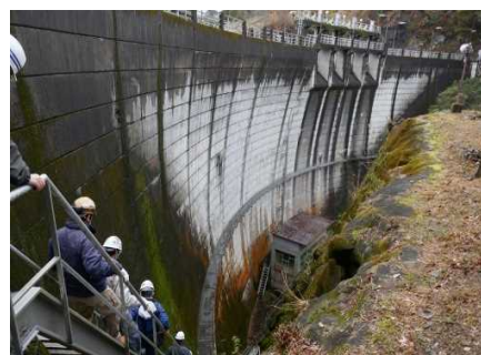
耐震照査技術支援(現地確認)
