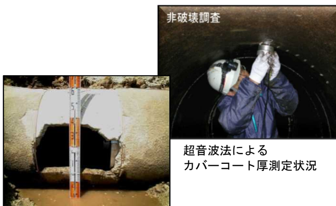
PC管の管体破損事故事例
