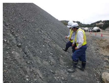
施工監理状況
