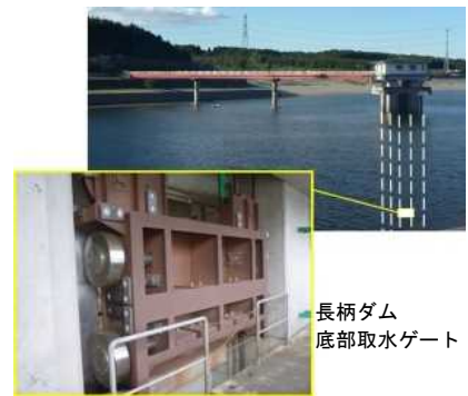
照査したアースダム放流設備の例
