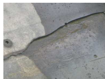
堤体下流面水平打継面の コンクリート欠損
