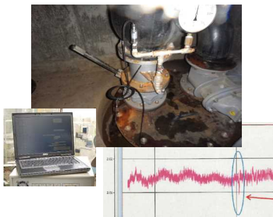
圧力センサーによる管路診断
