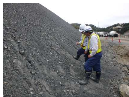
施工監理状況
