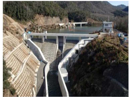
試験湛水中のダム
