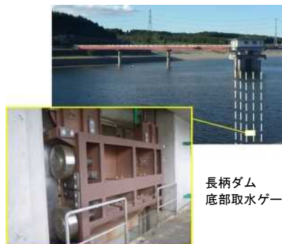
照査したアースダム放流設備の例
