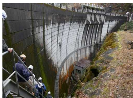
耐震照査技術支援(現地確認)
