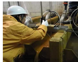
監視項目の計測状況の確認
