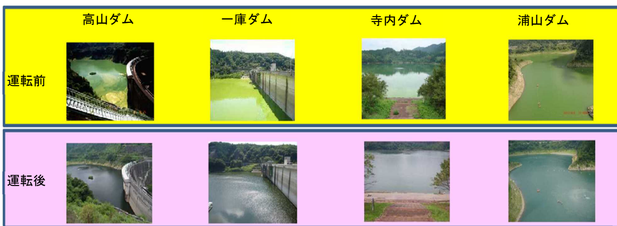
浅層曝気循環設備運転前後における貯水池の状況（運転後はアオコ抑制）
