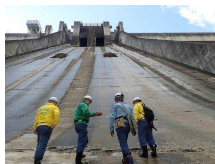
ダム洪水吐きの検査状況
