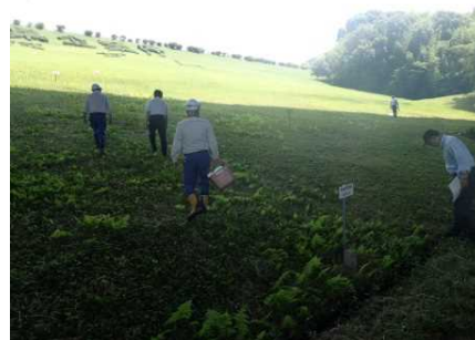
堤体法面の湿潤状況の確認
