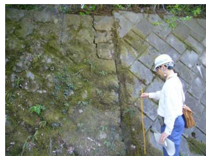
現地調査（擁壁の変状調査）
