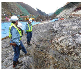
ダム基礎地盤の確認・評価
