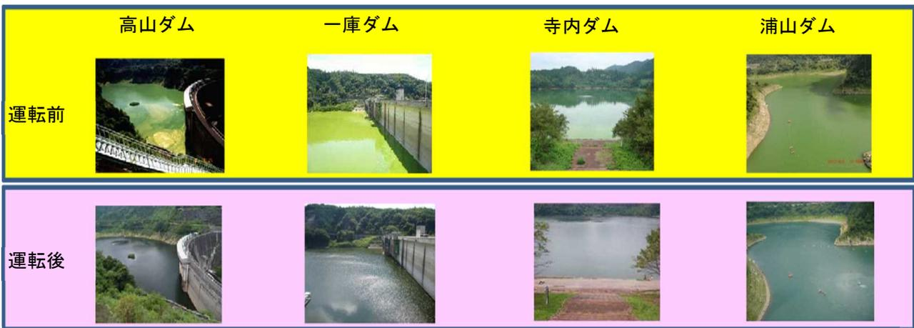
浅層曝気循環設備運転前後における貯水池の状況（運転後はアオコ抑制）
