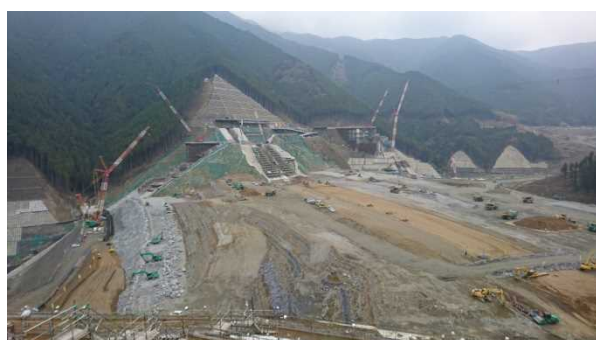
ロックフィルダム盛立状況
