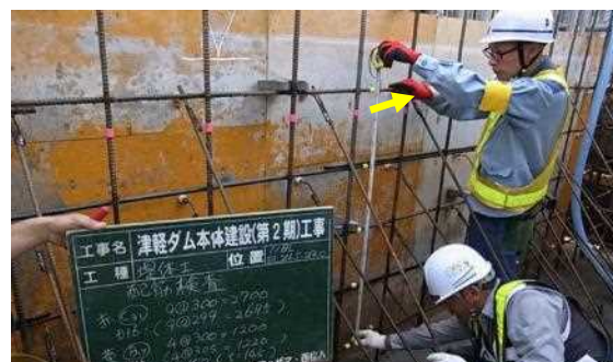
配筋検査(プロセスチェック)
