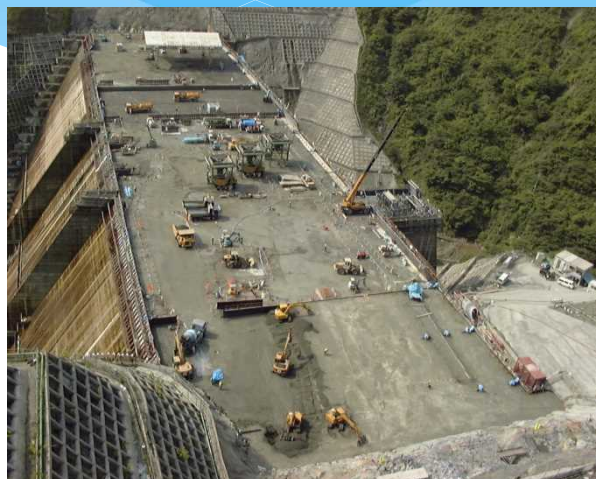
コンクリートダム施工状況
