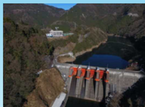
柳瀬ダムの下流「新宮ダム」
