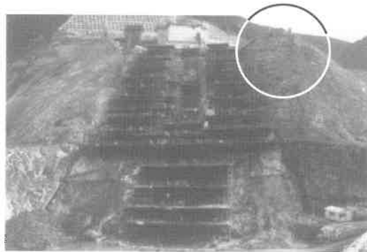
図-2 右岸岩盤の掘削状況。写真右手（上流側）の地山の頂上部分に岩盤地震計 R1 が設置されている。
