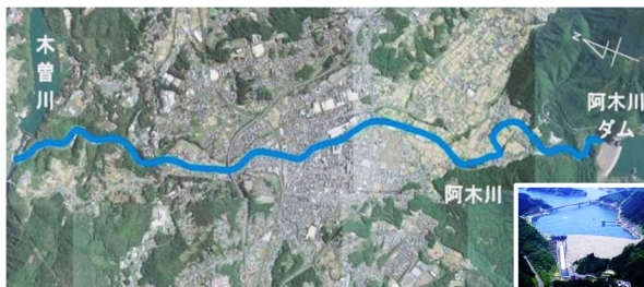
写真-1 阿木川ダム下流航空写真
