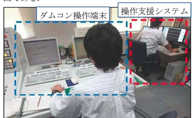
写真－2 ダムコンと操作支援システム
