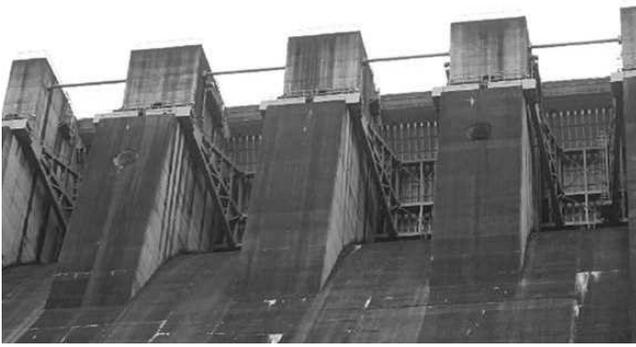
図-2 一般的なダム門柱とゲート
