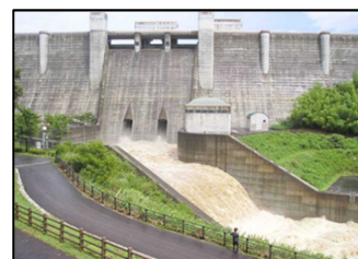
比奈知ダム現地放流状況 (水路幅 35m、長さ 132m、高さ 12~13m)
