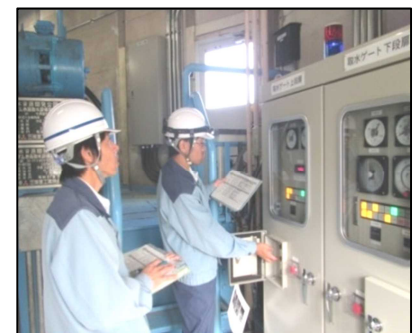
機側操作盤による検査状況
