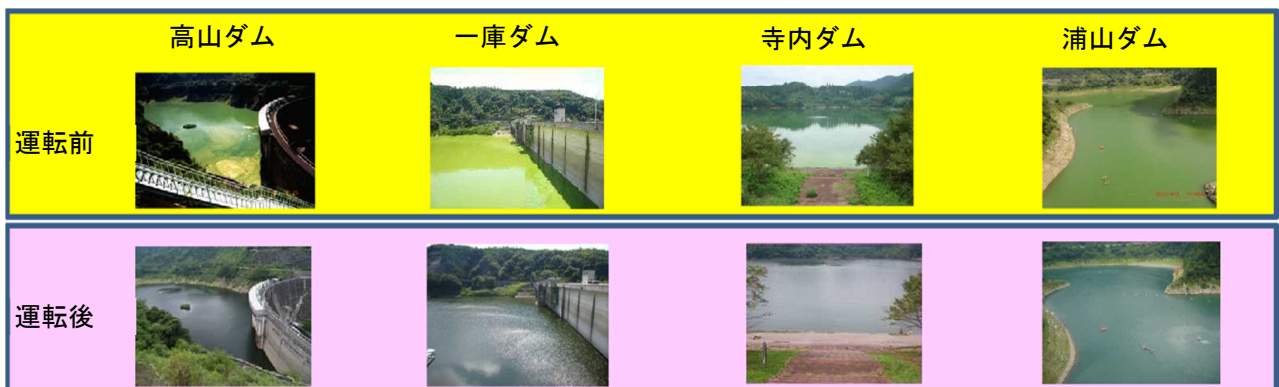
浅層曝気循環設備運転前後における貯水池の状況（運転後はアオコ抑制）
