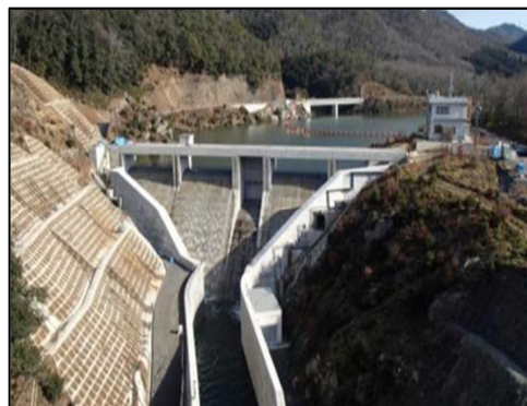
試験湛水中のダム
