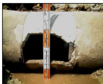
PC管の管体破損事故事例
