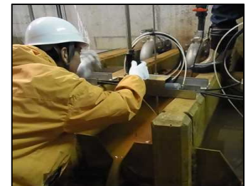
監視項目の計測状況の確認
