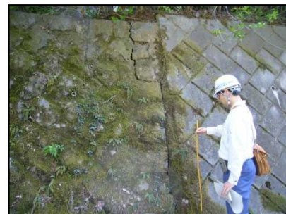
現地調査（擁壁の変状調査）
