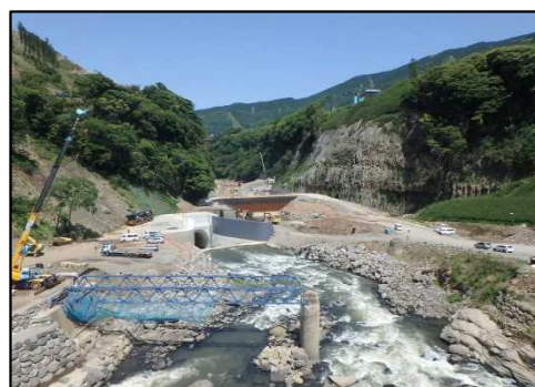
積算支援を行ったダム工事現場状況
