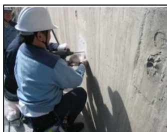
コンクリート健全度調査 (中性化深さ測定)
