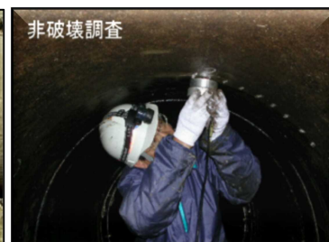
超音波法による カバーコート厚測定状況
