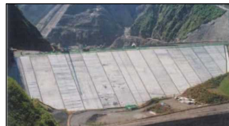
CFRDの施工例 （徳山ダム上流二次締切）
