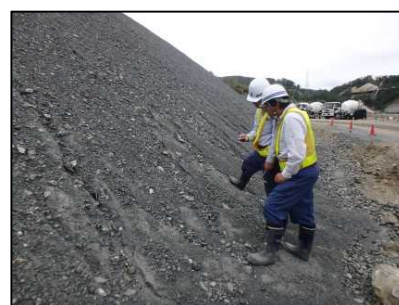
施工監理状況
