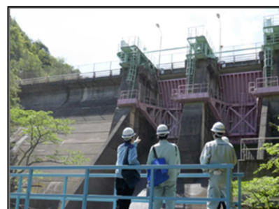
耐震照査技術支援(現地確認)
