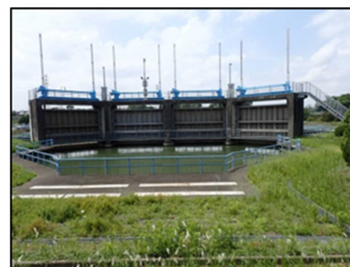
耐震照査対象施設
