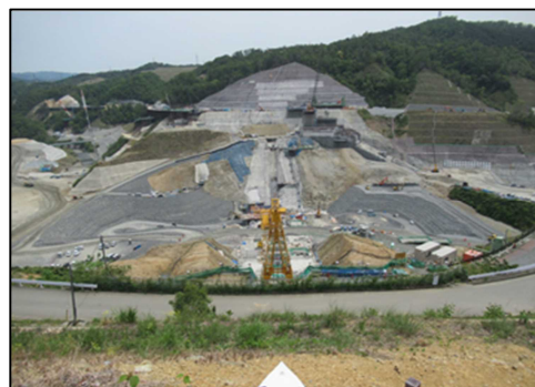
施工支援を行ったダム工事現場状況
