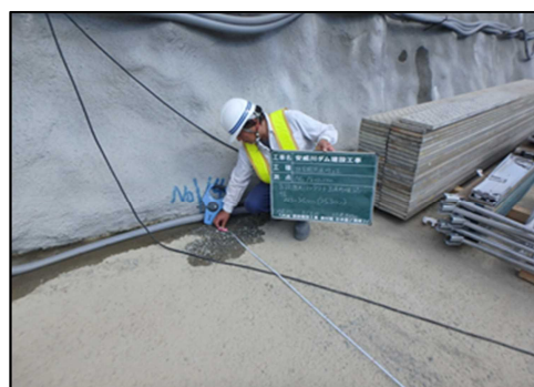
施工監理（現場立会い確認状況）
