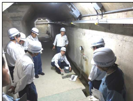
現地実習（下久保ダム）
