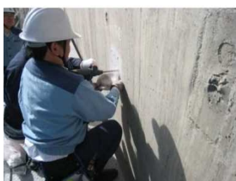
ドリル法による 中性化試験実施状況
