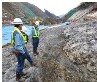
ダム基礎地盤の確認・評価
