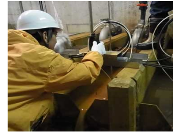
監視項目の計測状況の確認
