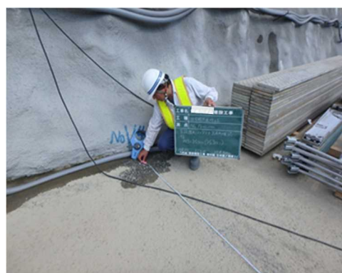
施工監理（現場立会い確認状況）
