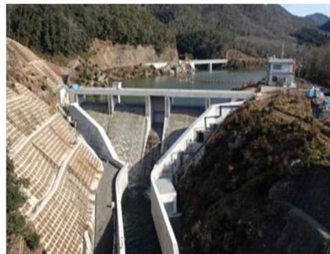
試験湛水中のダム
