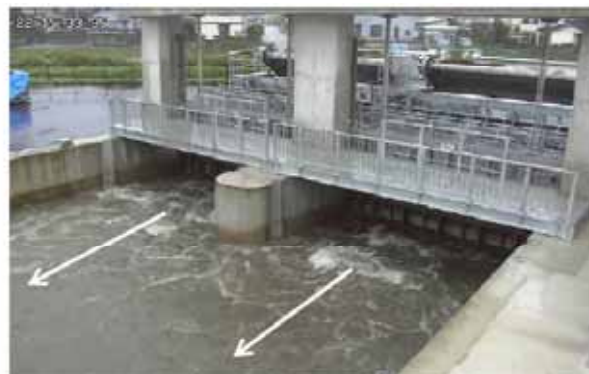
武蔵水路への洪水取込状況(佐間水門) 注
