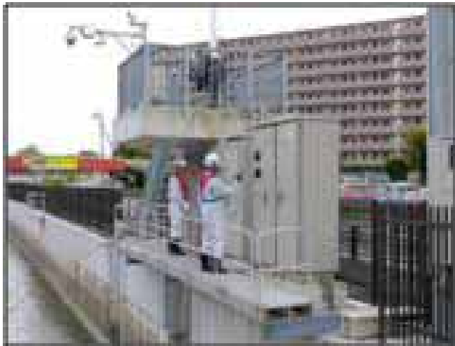
武蔵水路施設の巡視状況(赤見台放流口)
