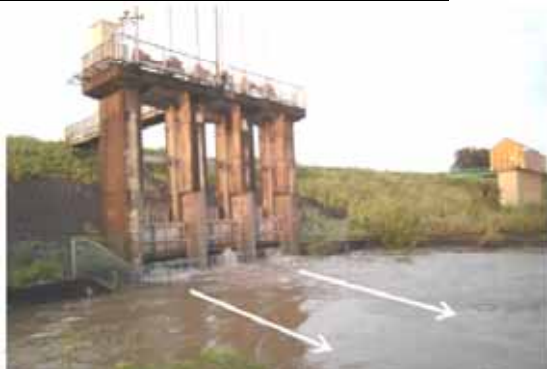
荒川への排水状況(糠田排水樋管) 注
