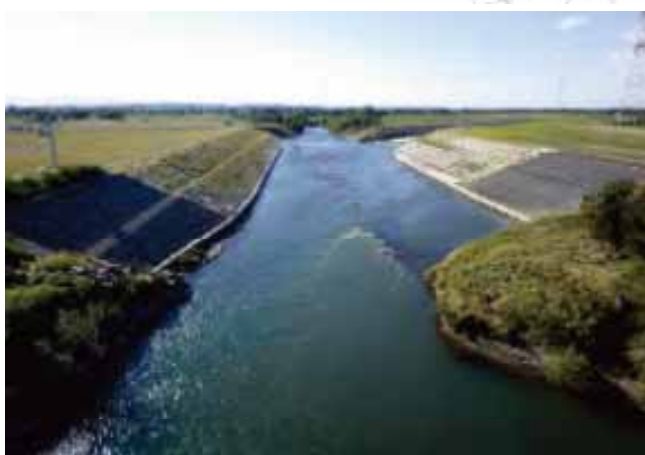
工事後：平成27年10月
