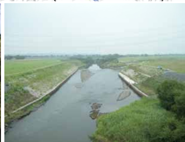
工事後：平成28年7月
