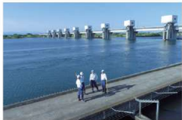
April 利根大堰（取水口）
