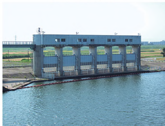
朝霞水路(宗岡取水口)
