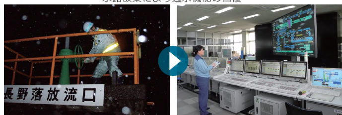
内水排除に関わるゲートの操作機能向上(遠方操作化)
