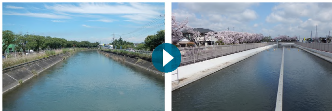
水路改築により通水機能の回復
