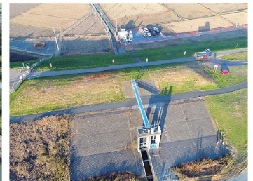
荒川連絡水道専用水路(前田樋管)
