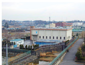
天沼揚水機場
