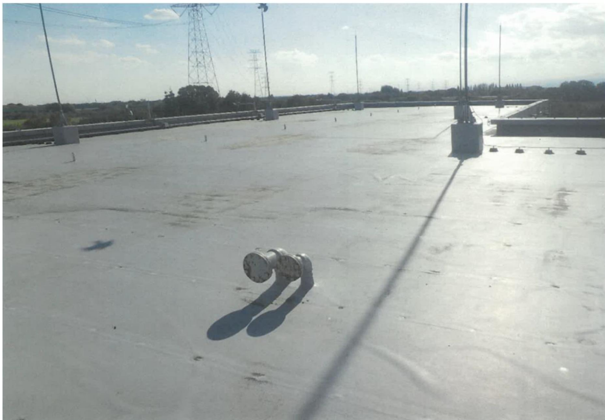
糠田排水機場屋上全景
