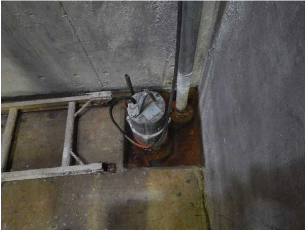
水中ポンプ【取替】・排水配管【既設流用】
