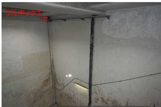
ラック配線・管内配線 (PE28)
