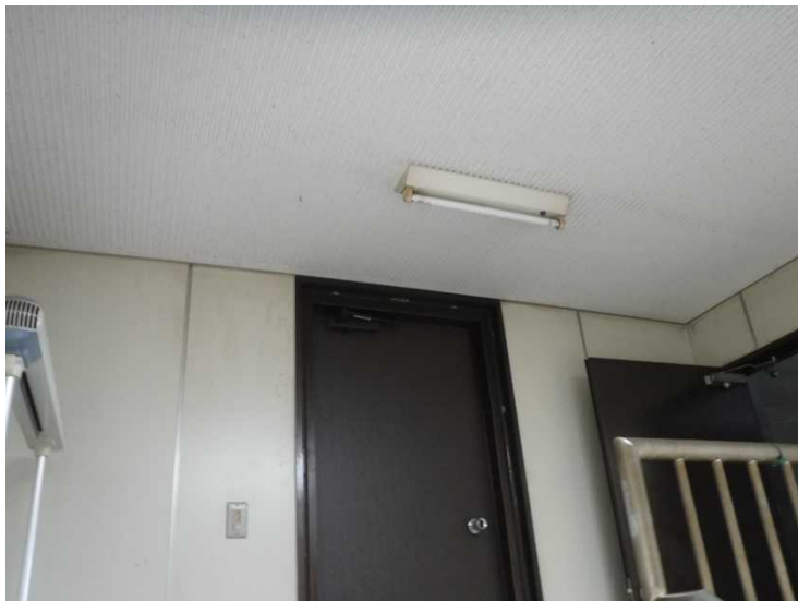
R階 図面室(⑱:2基)
