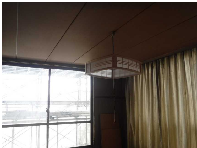
1階 仮眠室出入口(⑮:1基)
