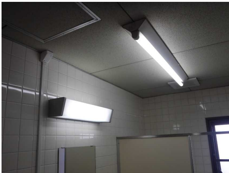
1階 女子トイレ(⑥:1基、⑫:1基)
