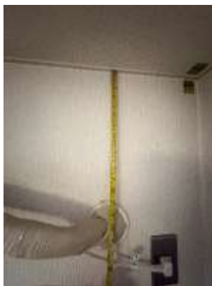
④天井から配管貫通部の穴芯まで（約 30cm）
