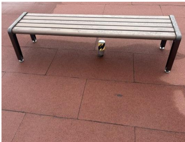
屋上の通気弁（椅子は移動可能）
