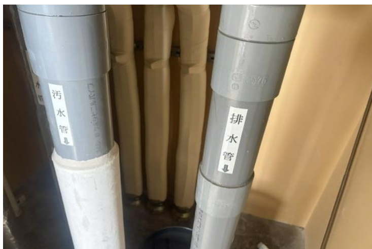
3階のパイプスペース
