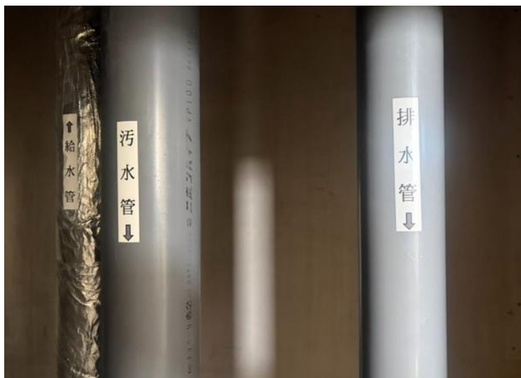
1階及び2階のパイプスペース
