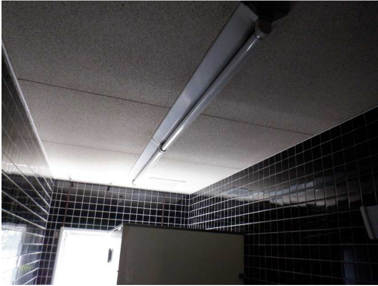
1階 トイレ(①:2基、⑦:1基)
