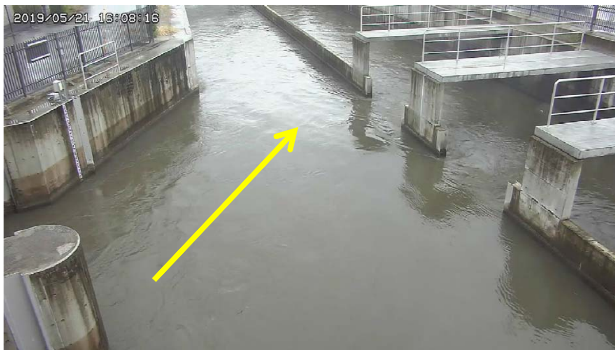
令和元年5月21日 16:08 佐間水門 水路側
