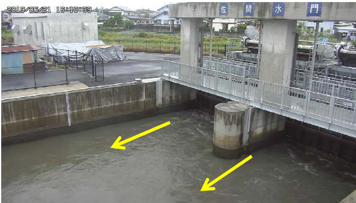
令和元年5月21日 16:10 佐間水門 水路側
