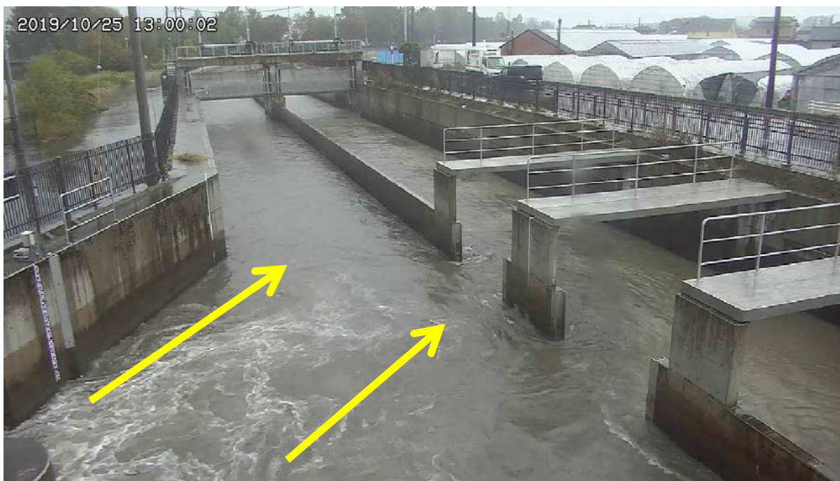
令和元年10月25日 13:00 川面水門 水路側
