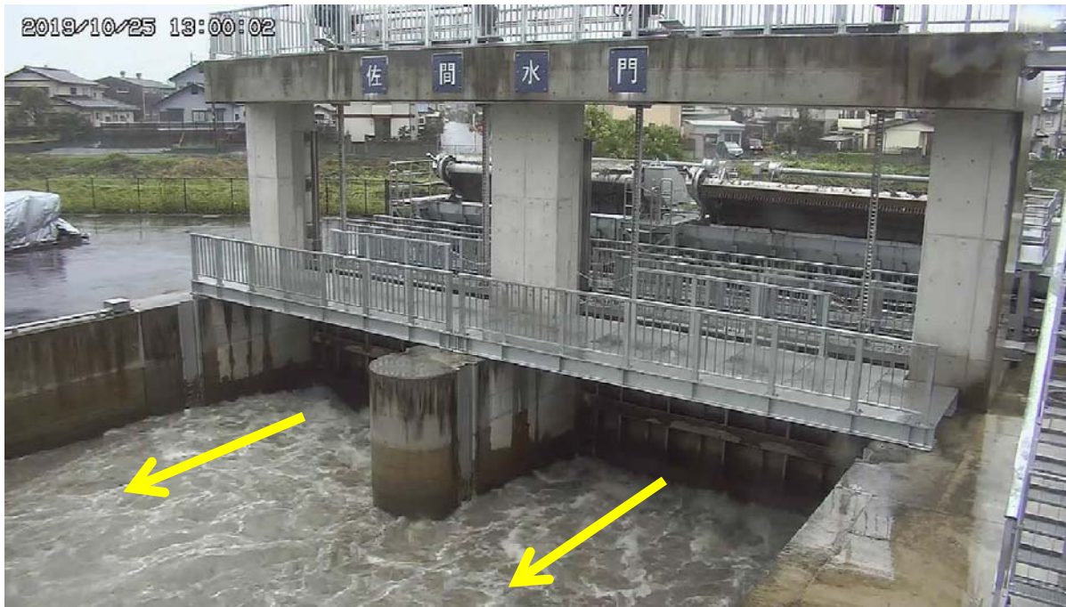
令和元年10月25日 13:00 佐間水門 水路側
