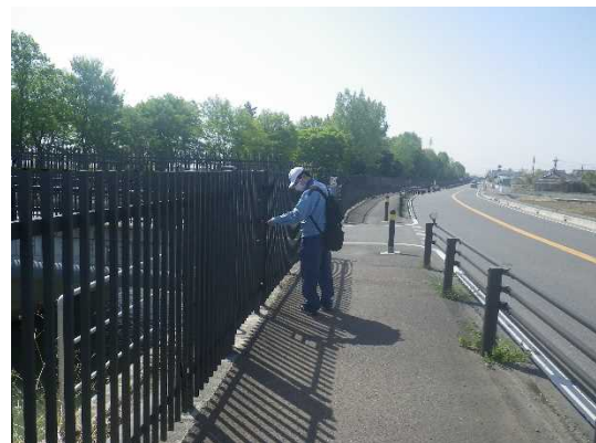
門扉施錠点検状況
