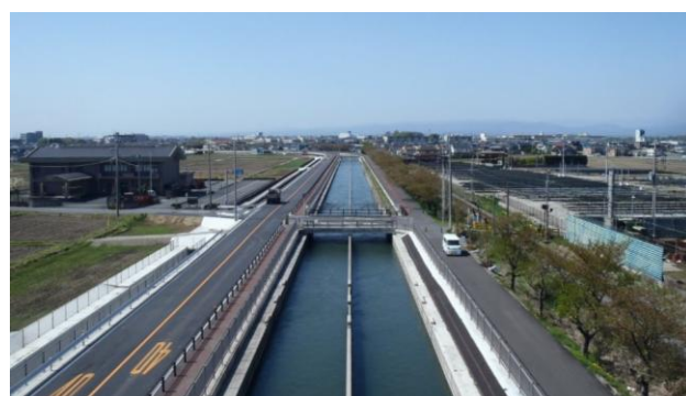
武蔵水路本体
