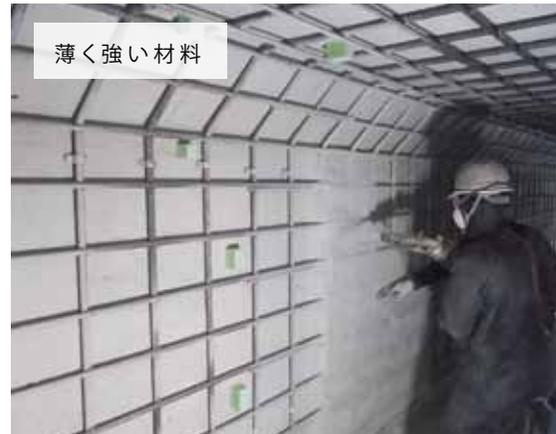
須加樋管は、取水口と大分水工をつなぐ利根川堤防を横断している施設で、通水能力を減少させないように耐震補強を行う必要があります。そのため、水路の内側を最小限の厚さで補強できるポリマーセメントモルタルを採用しました。
