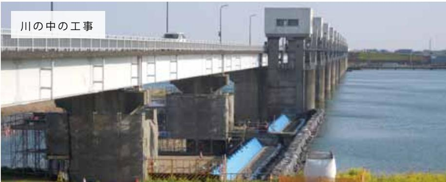
利根大堰本体の耐震補強は、利根川の河川内での工事のため大型土のう等で仮締切をし、工事ヤードを囲って水を遮断して工事を行います。
