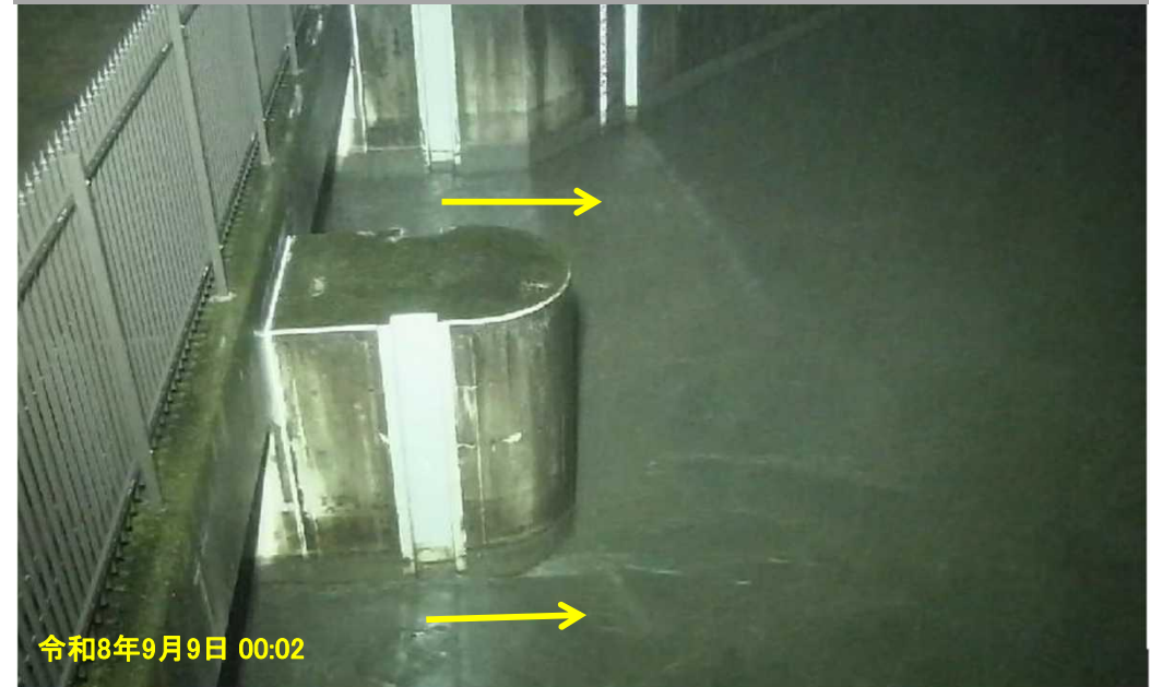
武蔵水路への出水取込状況(川面水門)
