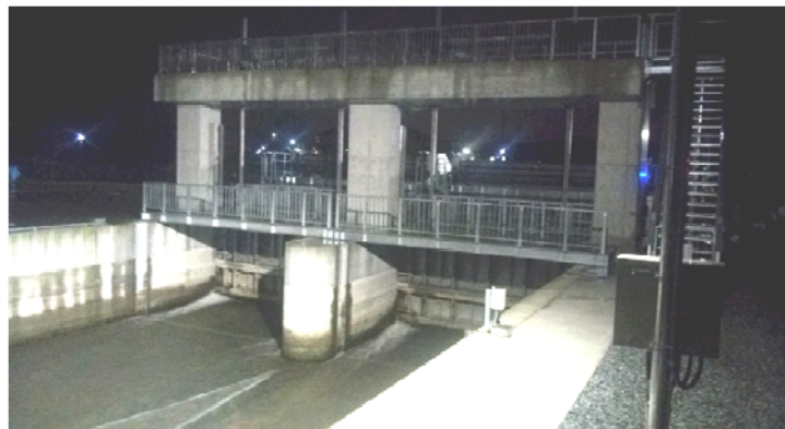
忍川(佐間水門地点)洪水取込状況
