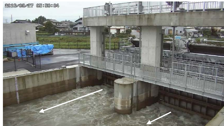
武蔵水路への洪水取込状況(佐間水門)
