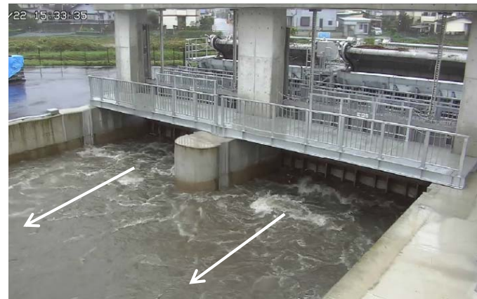
武蔵水路への洪水取込状況(佐間水門)
