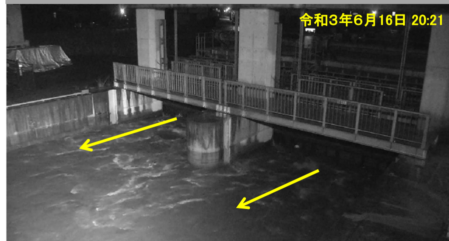
武蔵水路への出水取込状況(佐間水門)
